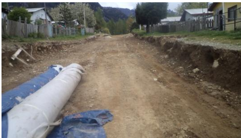
Fotografía N° 7. Camino en construcción Villa Mañihuales
