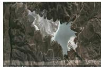
Fotografía satelital del Tranque de Relaves, muestra depósito de áridos finos y nivel de agua.
