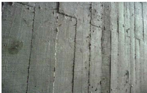
HORMIGÓN CON TEXTURA DE MADERA
