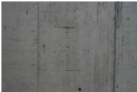
HORMIGÓN A LA VISTA
