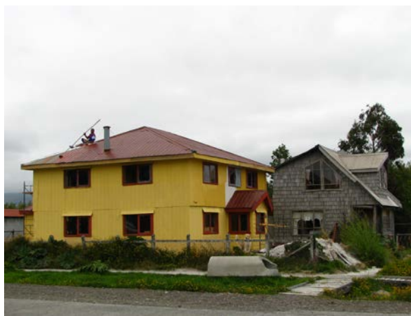
Trabajador pintando una cubierta Fuente: colección personal, febrero 2013
