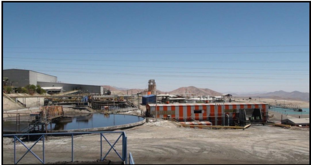
Figura Nº 16 Espesadores Planta Concentradora – El Salvador
