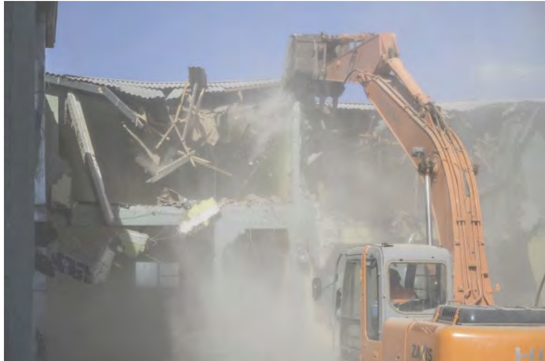
Fotografía derecha 6: Demolición de blocks de vivienda social en Francisco Coloane en Bajos de Mena, Puente Alto Fuente: Radio Cooperativa
