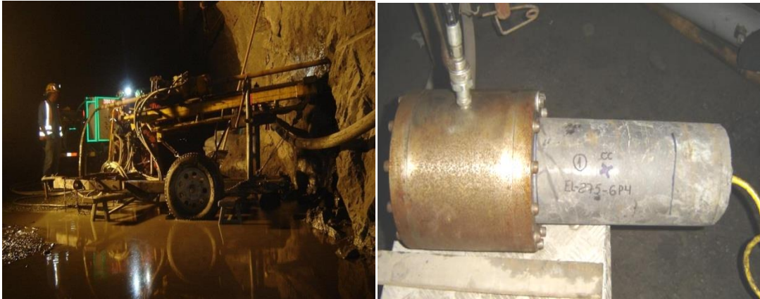
Figura 27. Equipo de perforación y testigo obtenido.
