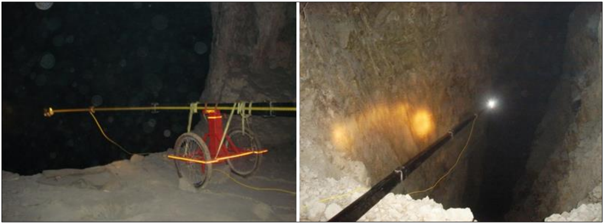
Figura 17. Sistema de monitoreo CMS (Facilitado por Mina A).
