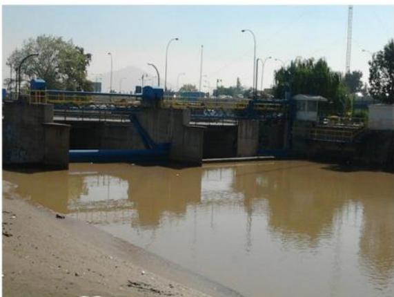
Represa a la altura de Manuel Rodríguez. Posterior a este punto las paredes de la riberas dejan de estar cubiertas de cemento, para dar paso a la presencia intermitente de gaviones.
