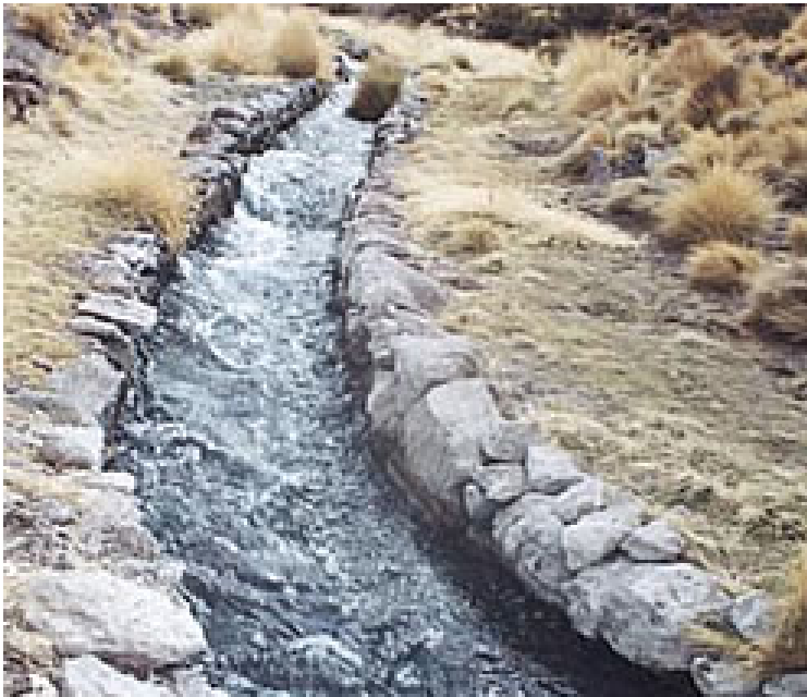
4.- Obras de encauzamiento realizadas por “The Antofagasta and Bolivian Railway Company Limited” con el objeto de aprovechar de mejor manera el caudal del Silala.
