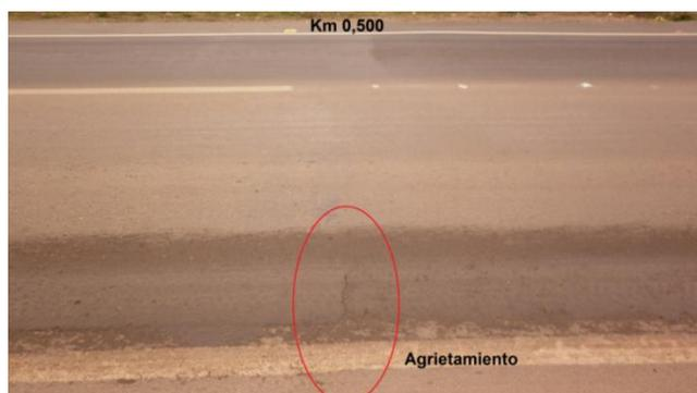
**Figura 4-27. Agrietamiento transversal en la junta (Km 0.500, faja izquierda). Inspección superficial concreto asfáltico en capa de rodadura (29.07.2013).**
