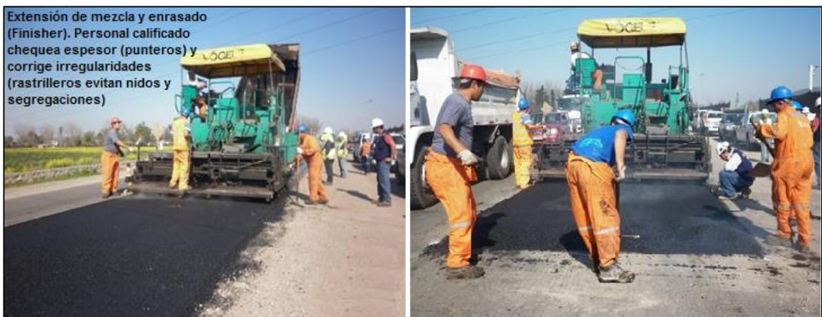
**Figura 4-14. Colocación de la mezcla en el espesor proyectado.**
