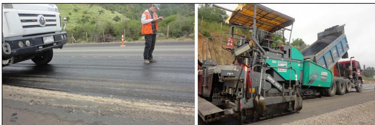
**Figura 4-47. Preparación de la superficie (riego de liga) y carga de la finisher.**
