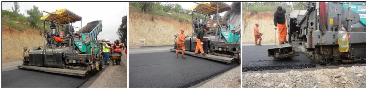
**Figura 4-49. Colocación de la mezcla asfáltica modificada al espesor proyectado.**
