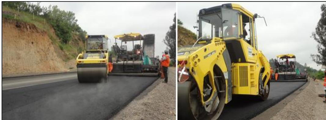
**Figura 4-50. Extensión y compactación en pista N° 2 (rodillo liso).**
