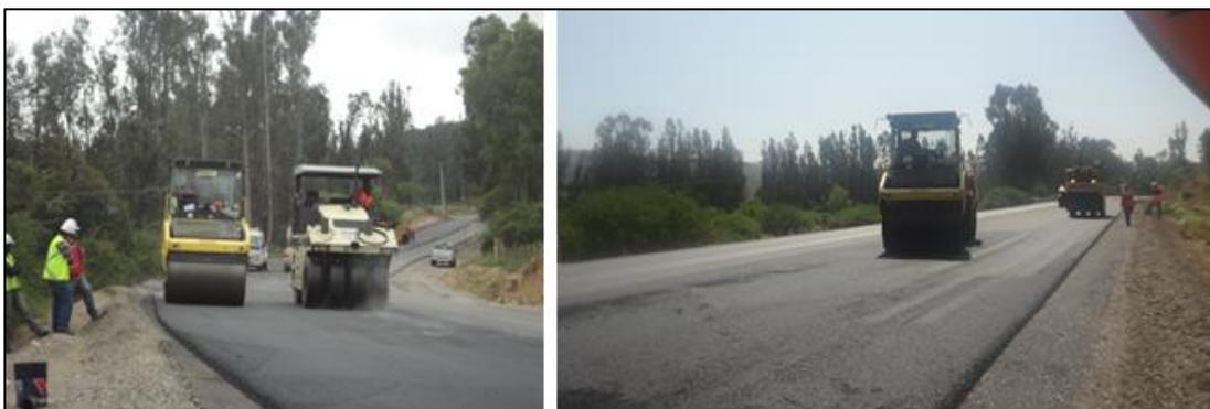
**Figura 4-51. Compactación en pista N° 2 (rodillo liso y rodillo neumático).**
