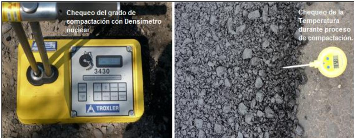
**Figura 4-16. Chequeo de la densidad (densímetro nuclear) y la temperatura durante la compactación.**
