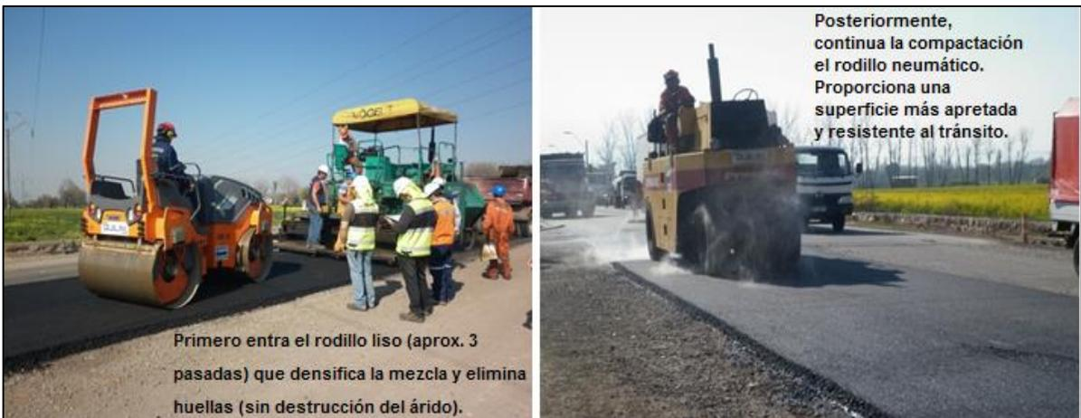
**Figura 4-15. Compactación de la mezcla (rodillo liso y rodillo neumático).**
