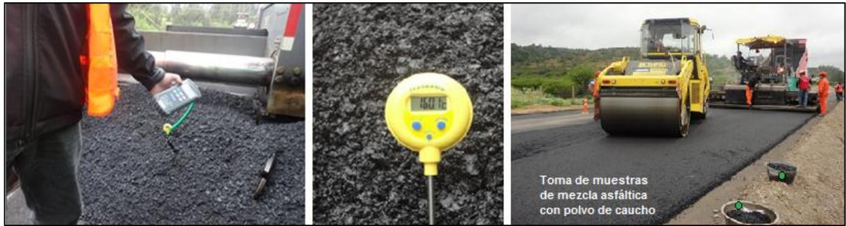
**Figura 4-48. Control de la temperatura durante la extensión de la mezcla asfáltica modificada y muestreo (en finisher).**
