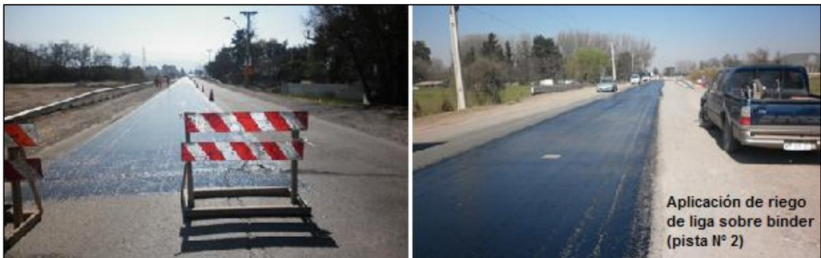
**Figura 4-12. Preparación de la superficie (riego de liga) para colocación de la mezcla asfáltica modificada.**
