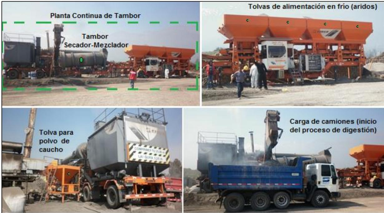
**Figura 4-11. Confección de la mezcla asfáltica modificada con polvo de caucho en la Planta Asfáltica.**
