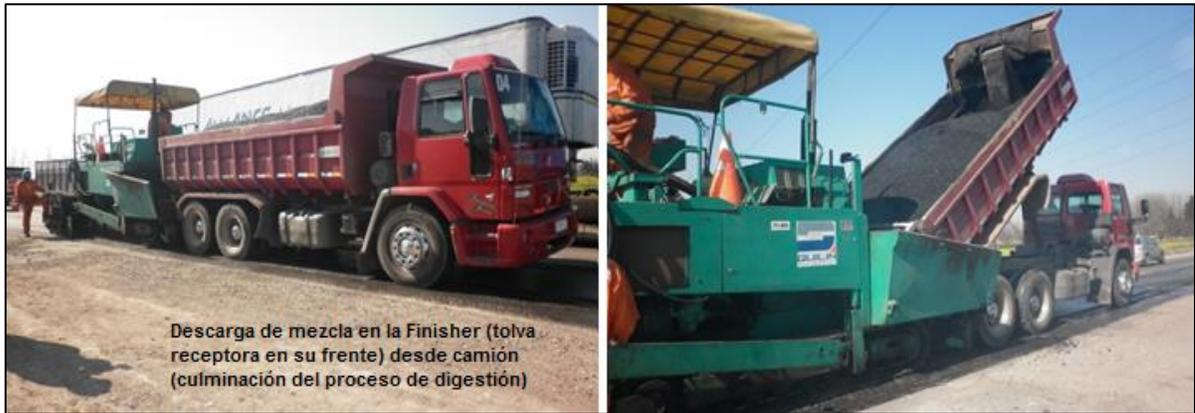
**Figura 4-13. Transporte de la mezcla en camiones cubiertos y carga de la finisher.**
