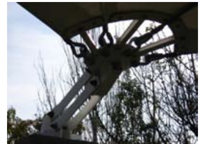
Imagen 61. Detalle de cubierta patio villa grimaldi. Fuente: www.plataformaarquitectura.cl .
