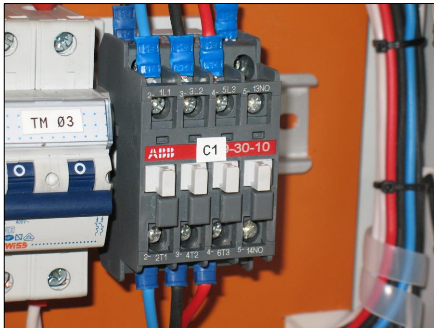
Figura 52: Contactor trifásico.
