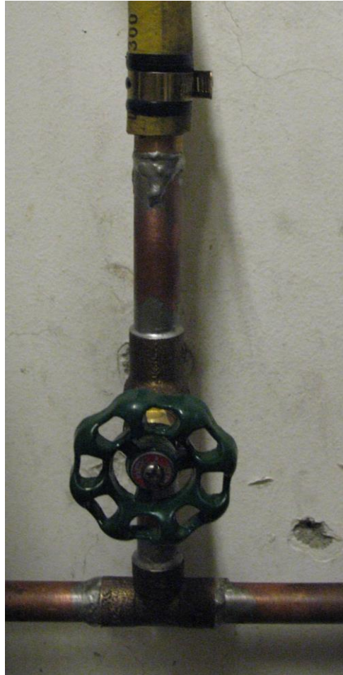
Figura 62: T, válvula de compuerta y manguera de alimentación instalada en la línea del laboratorio.
