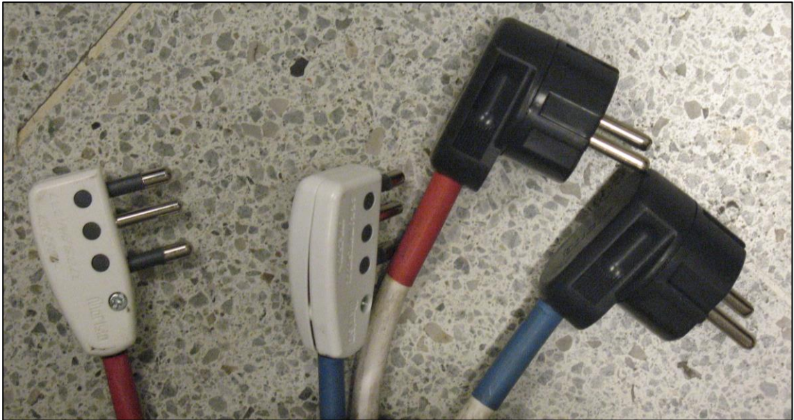
Figura 59: Termocontráctiles instalados en los enchufes.
