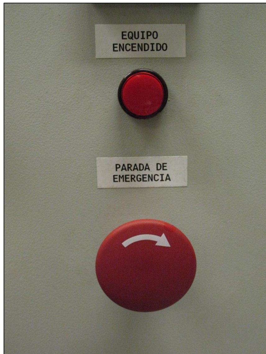
Figura 51: Luz piloto roja y botonera de emergencia.
