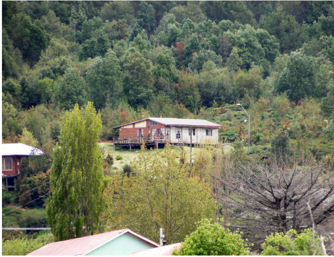
Imagen: Edificio simple que muestra techos con pendiente. El cual está construido sobre pilotes, con la materialidad y expresión local. Fuente: Autor
