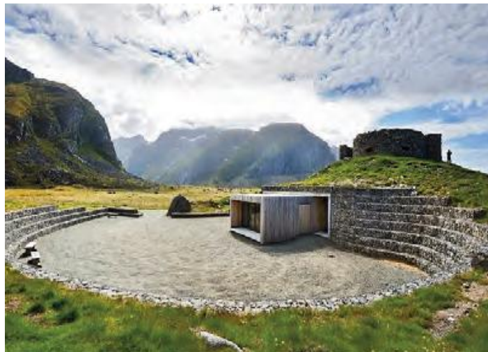
Imagen: Senderos y edificio parte del sistema integrado de equipamientos en Ruta Escénica Lofoten, Noruega Fuente: Criterios y directrices de diseño de equipamiento en rutas de belleza escénica.
