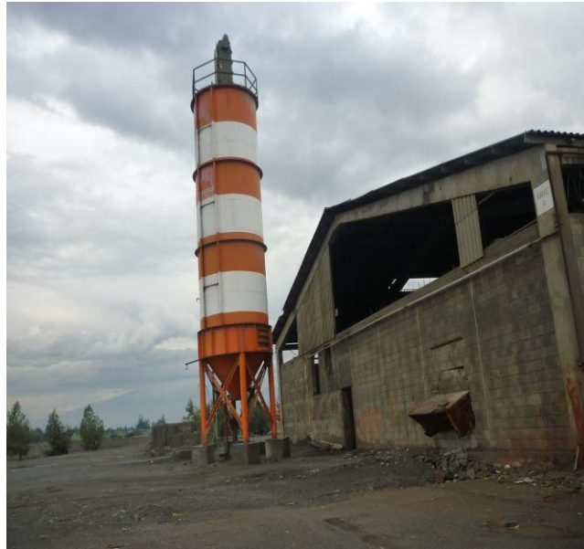
Fig 3 Silo para almacenamiento de cemento granel instalado en terreno del cliente.
