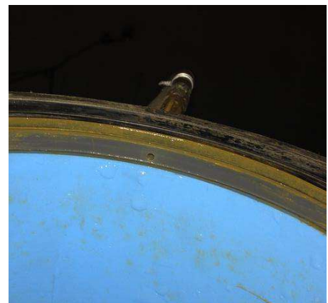
Figura 7 Flange perforado para toma de presión de placa orificio.
