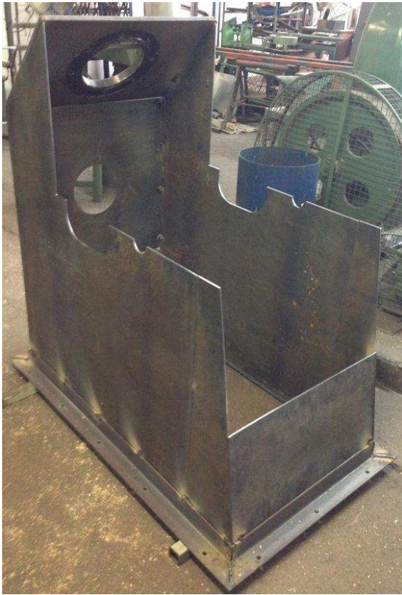
(a) Inicio de montaje; Soldadura
