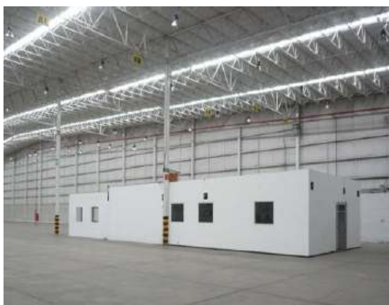
Ilustración 12: Referencia estándar oficina interior bodega.
