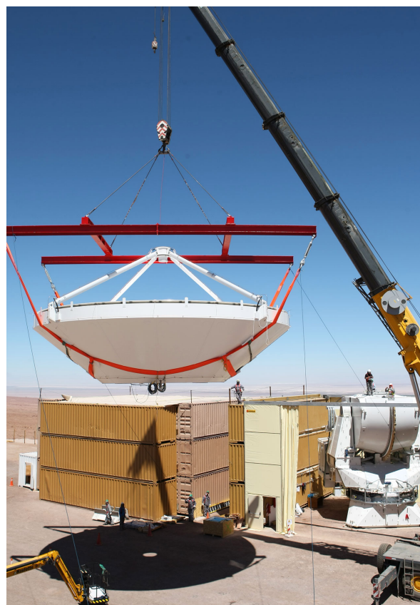
Primera antena Europea siendo armada Fuente: www.eso.org
