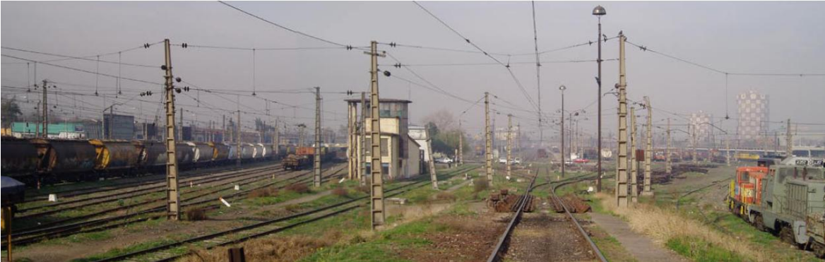
Imagen : Patios de maniobra de ferrocarriles de Estación Central, ex Alameda. En Proyecto de Título 2005 "Estación Intermodal: umbral de acceso al centro para la zona sur poniente" de Carolina Oteo.
