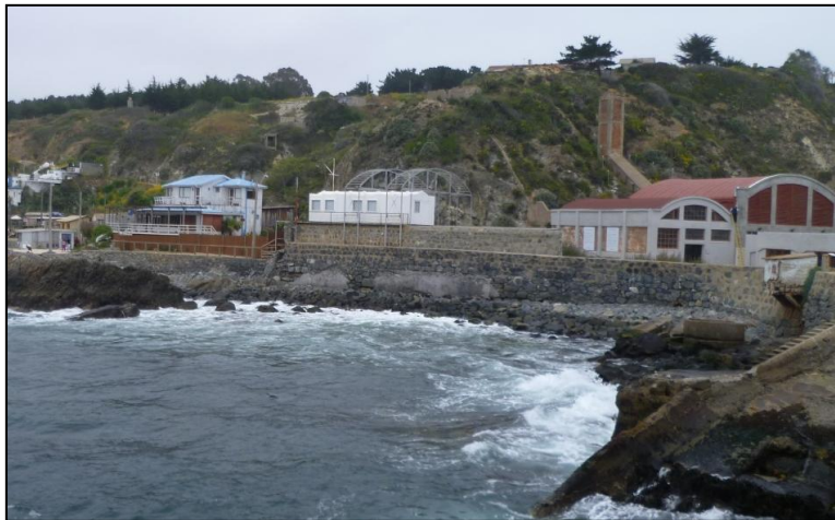
Fig. 70: Caleta Quintay. Borde costero con estructuras de protección en la plataforma basal del acantilado. Fuente: Colección personal.
