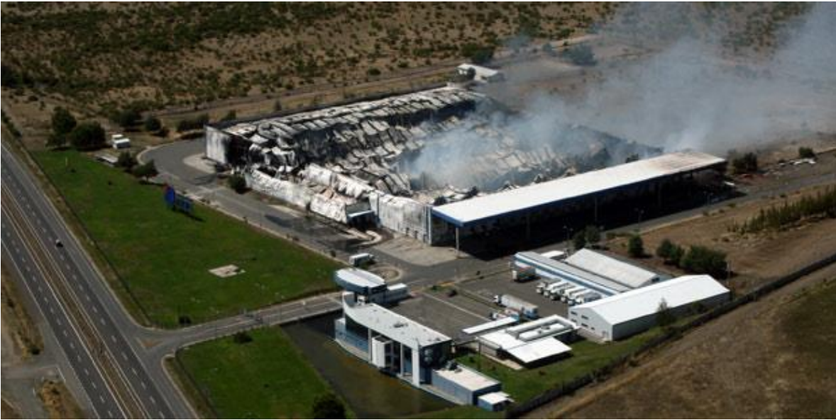
ANEXO 05: Fotografía de Destrucción Centro Distribución Rabié, Chillán viejo.
