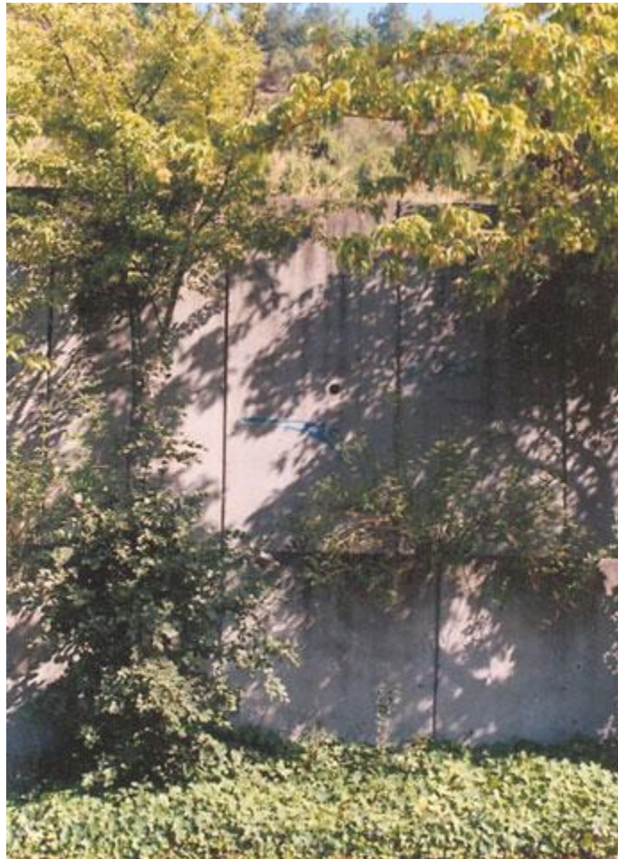
Fig. 15. Muro de contención al norte de calle El Cerro.
