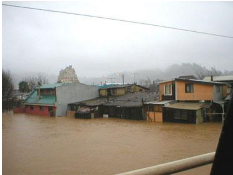
Fig.7. Inundación de casas en Concepción. Julio 2006.
