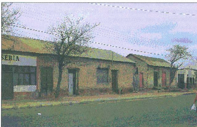
Fig.11. Sector Las Compañías. Dominio de las viviendas de adobe Fig. 11. Las Compañías. Adobe houses.
