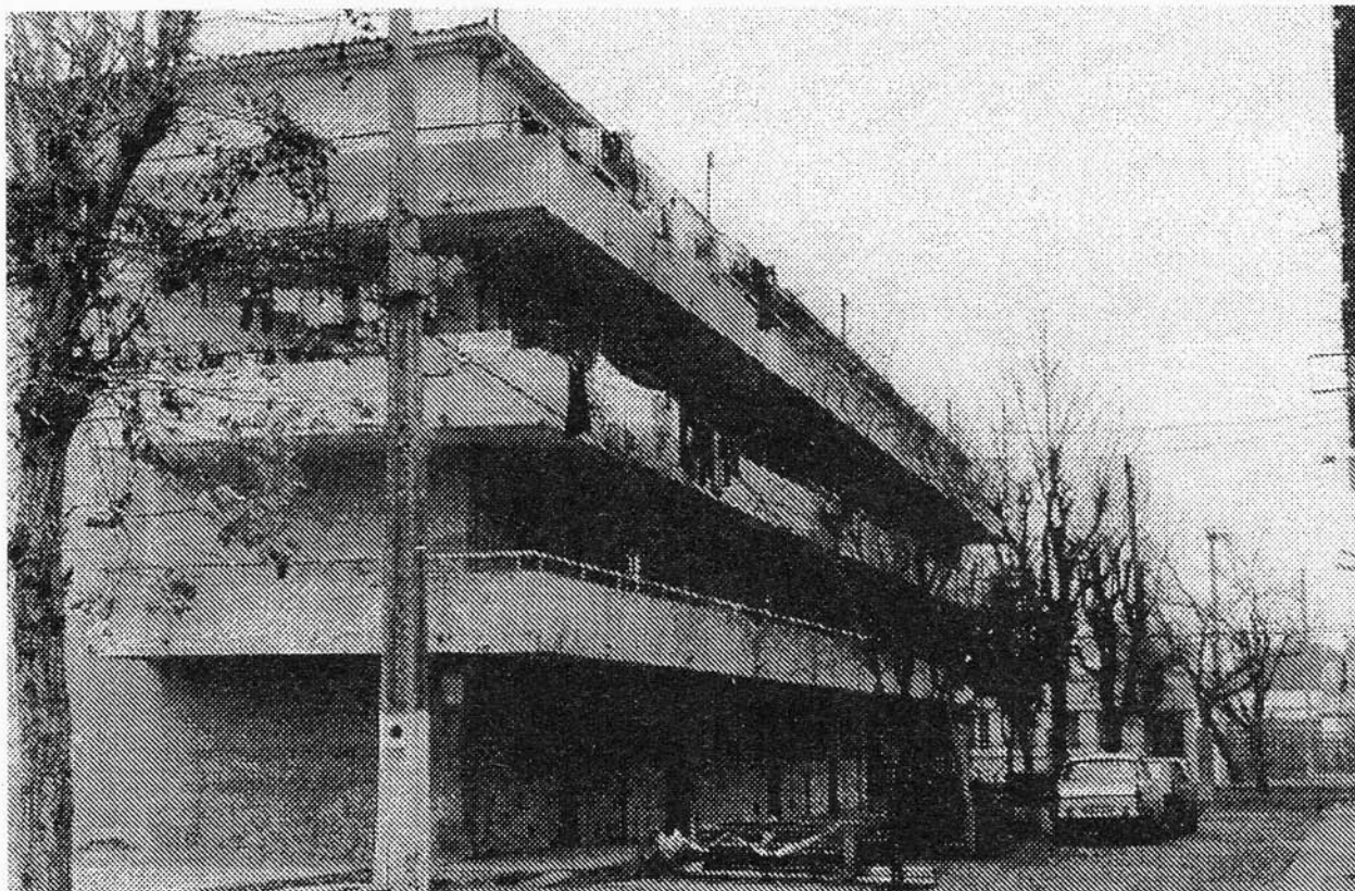
Fotos 2 y 3.- La prioridad que se da al 'uso efectivo y actual' de las obras explicaría la tolerancia al deterioro, aún cuando al emitir un juicio se lo asocie sólo con 'antigüedad'. (Población Huemul II (1941), Santiago. Tomada en julio de 1986. Fte.: Centro de Documentación del Instituto de la Vivienda, CDI)
