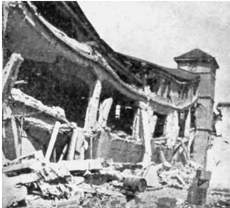
Ruinas del pabellón de la Fábrica de Paños Bellavista.
