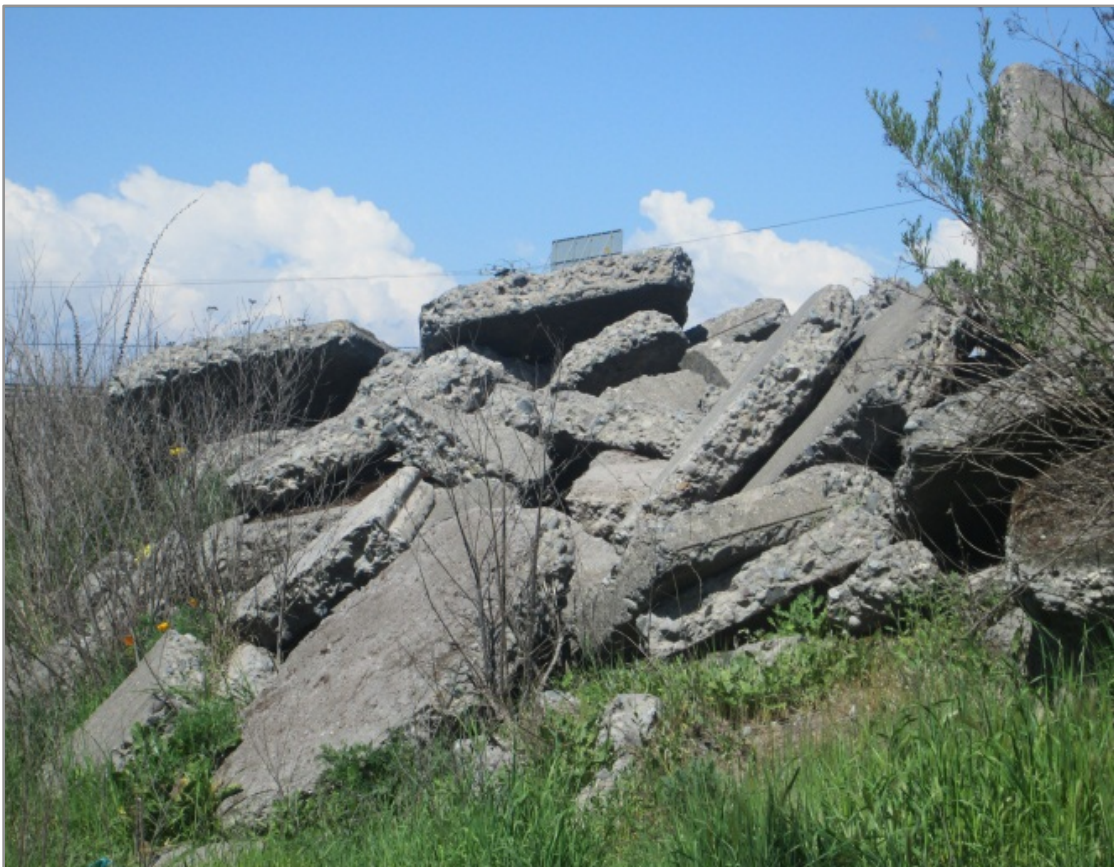
Imagen N° 16, Escombros del puente Teno derribado tras el temporal de 1986, nadie los ha removido de la ribera. (Karen Narvaez)
