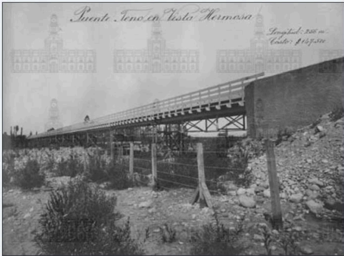
Imagen N°2, Puente del río Teno, observado desde la ribera sur (Fotografías antiguas de Teno)
