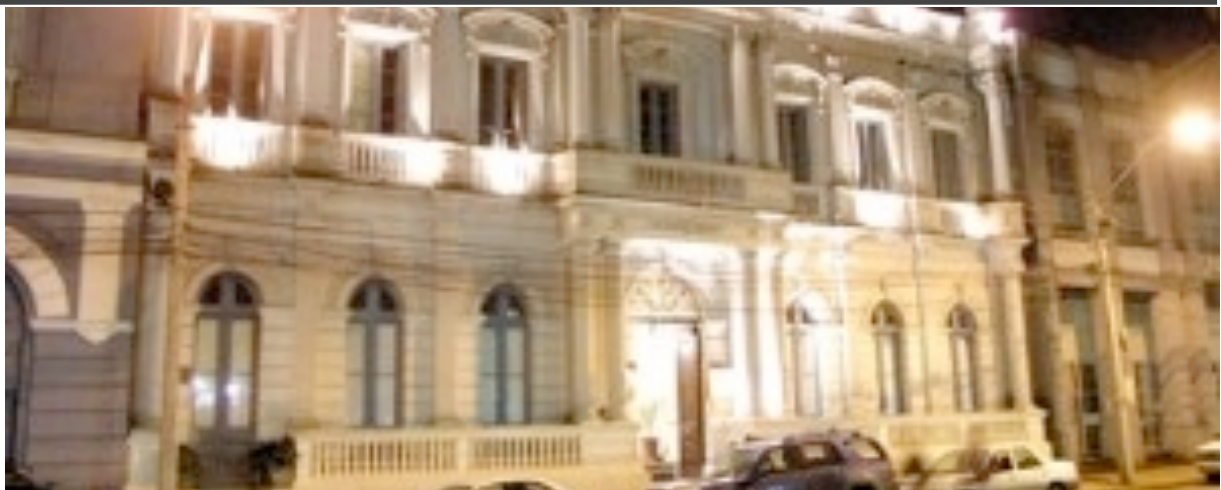
Terremoto 2010, edificio La Prensa, Plaza de Armas, Curicó. Fuente: Diario La Prensa.
