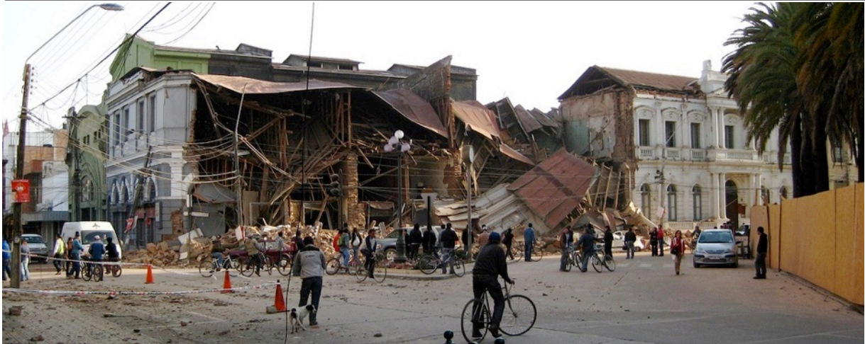
Terremoto 2010, edificio La Prensa, Plaza de Armas, Curicó. Fuente: Fotos antiguas de Curicó.
