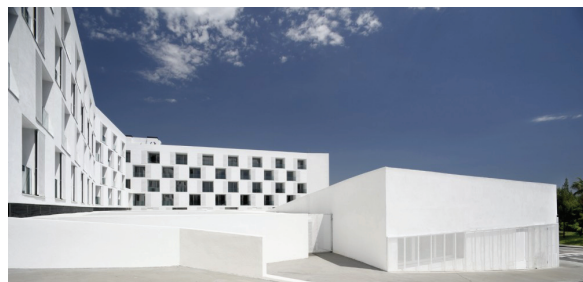
81 Viviendas tuteladas para mayores y equipamiento comunitario cultural, Can Travi, Barcelona.
