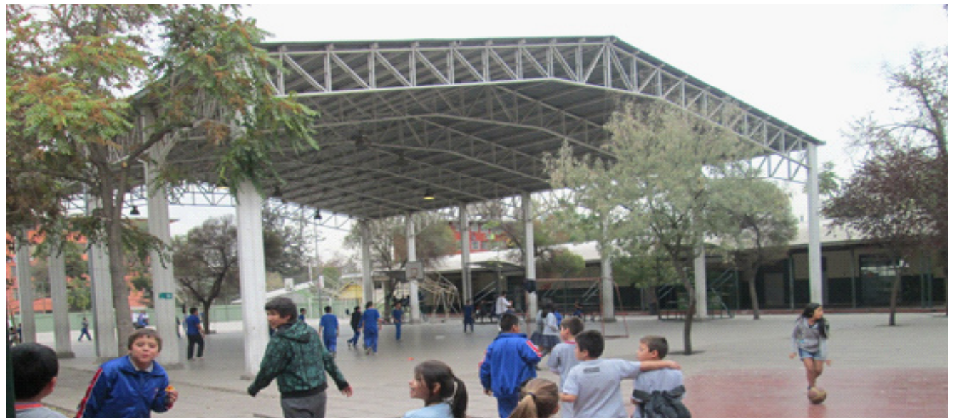
Patio techado, Multicancha Escuela Nueva Zelanda, Independencia.
