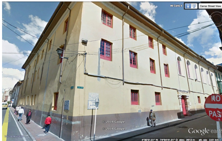
Imagen 93: Fachada Actual. Google Earth. 2014
