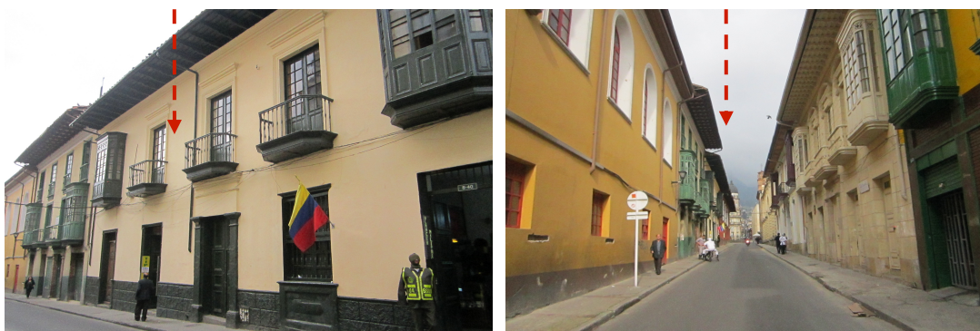
Imagen 29: Eje vial de la calle 8a. Calle San Cristóbal. Ref. Archivo fotográfico MGC/ CRC. 2013
