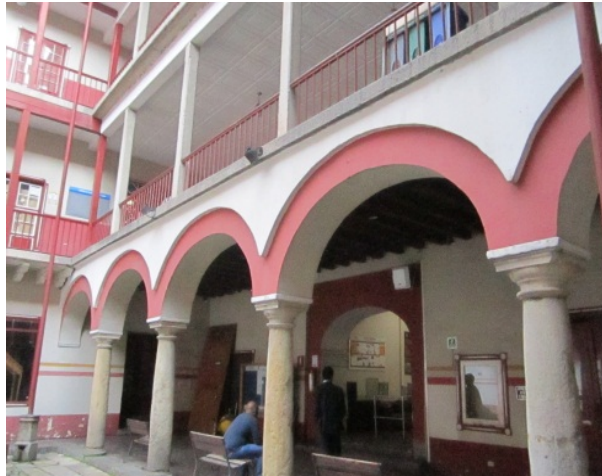
Imagen 103: Arcada corredor de acceso, estado actual. MGC. 2014
