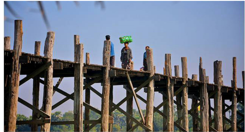
Estructuras y Soportes
