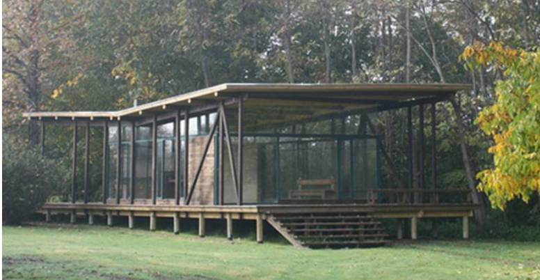
Quincho en Pirque 332 Arquitectos
