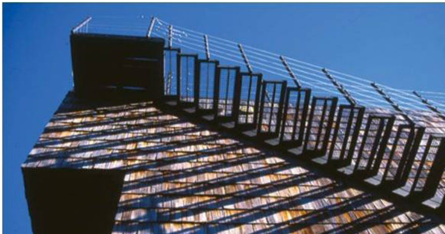
Permeabilidad barandas y escaleras
