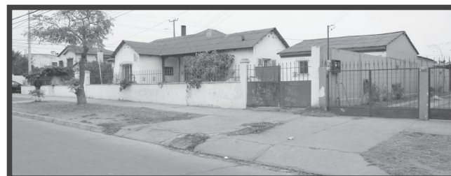
Imagen 16 _Foto de viviendas que pierden identidad del sector.
