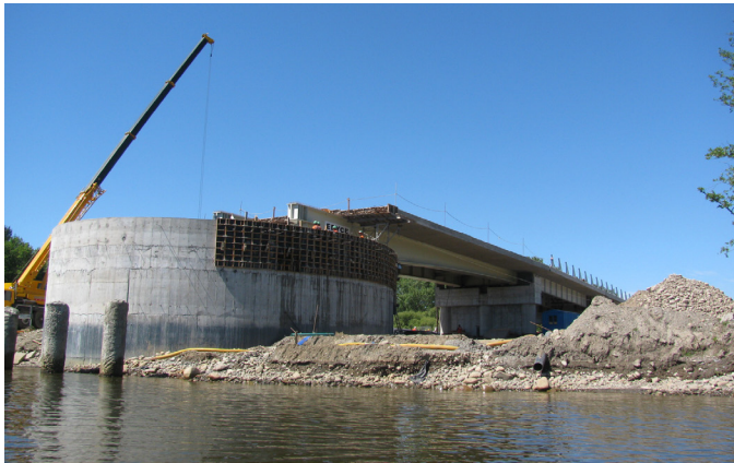
Figura 38_ Puente Cau-Cau en Construcción Fuente_ Elaboración Propia
