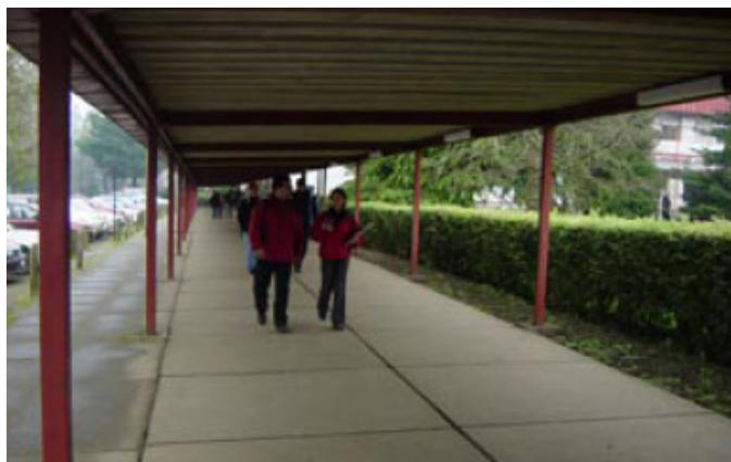
Figura 26_ Circulaciones Techadas UACH Fuente_ Elaboración Propia
