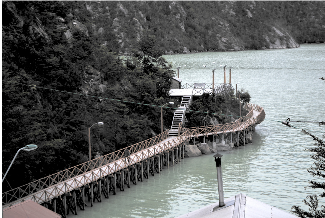
Pasarela costanera Fuente propia
