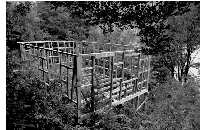
Estructura de ciprés sobre pilotes, Tortel. Fuente propia
