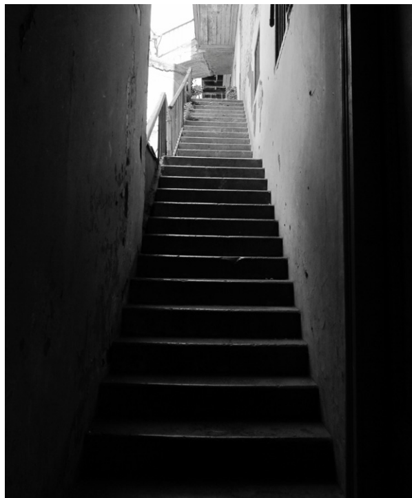
Imagen 52 | Escalera acceso al colectivo | Fotografía personal
