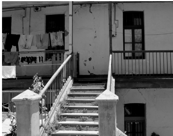
Imagen 61 | Escalera acceso tercer piso bloque Francia | Fotografía personal
