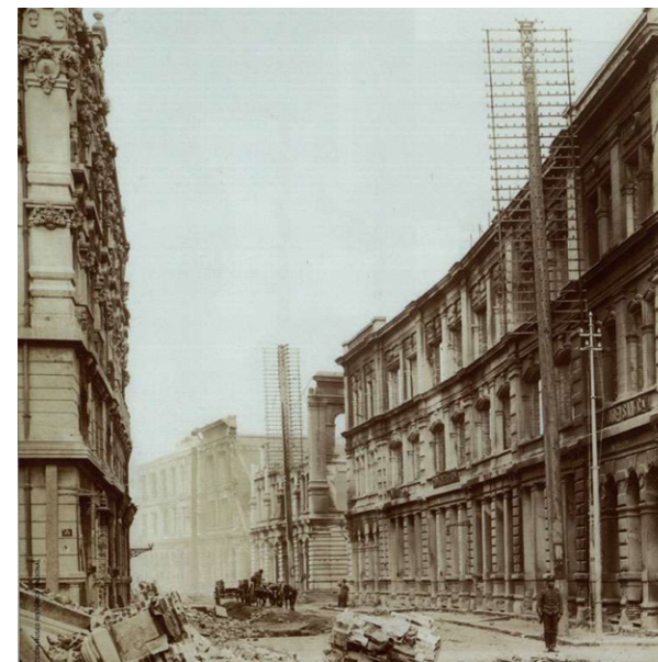
Imagen 1 | Terremoto de 1906 | Fuente: CA 142, 2006
