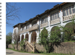
Estado actual fachada principal
