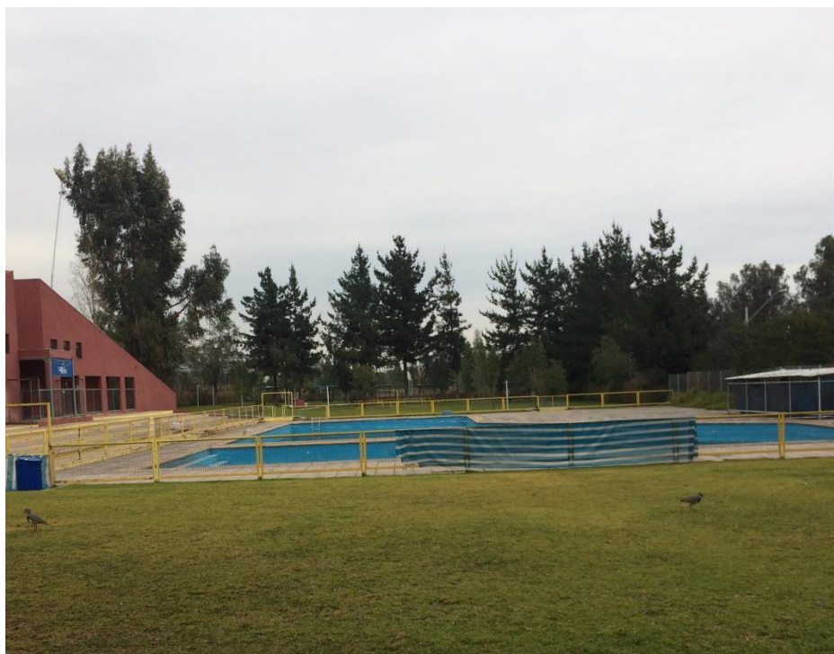
Ilustración 10: Foto de Piscina Municipal. Fuente: Elaboración propia
