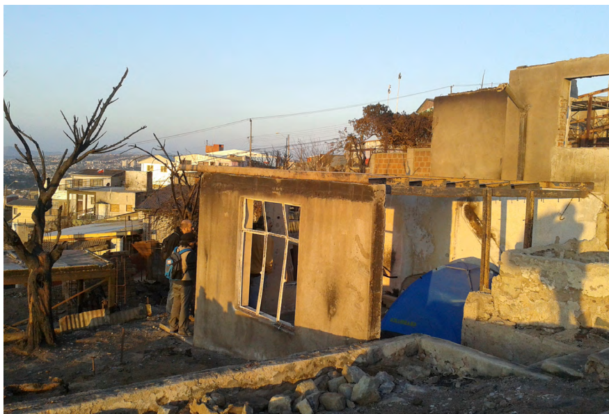
Imagen 2. Viviendas post incendio (fuente: Verónica Maturana).
