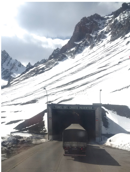
Figura 14: Túnel Internacional Cristo Redentor. Chile & Argentina
