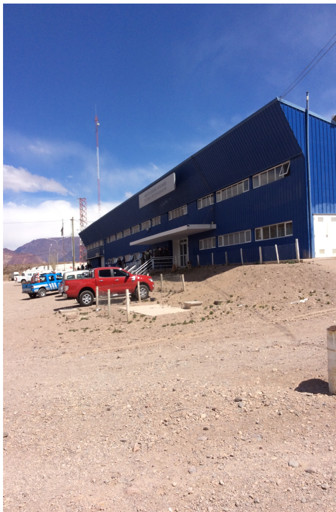
Figura 16: Complejo Fronterizo Uspallata. Argentina
