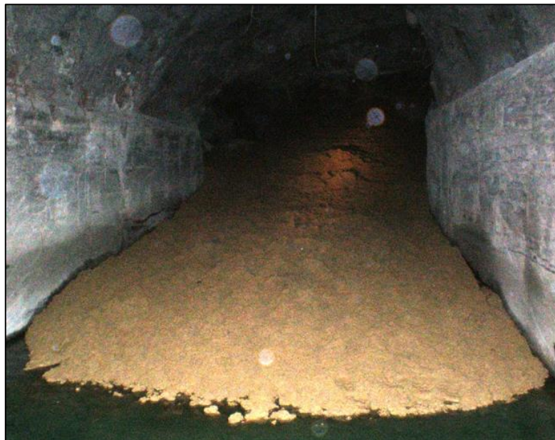
Figura 46: Bombeo producido en el punto de extracción 11 24H.
