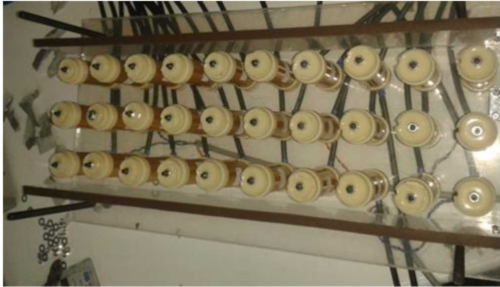
Figura 7-11: Celdas instaladas con sus soportes
