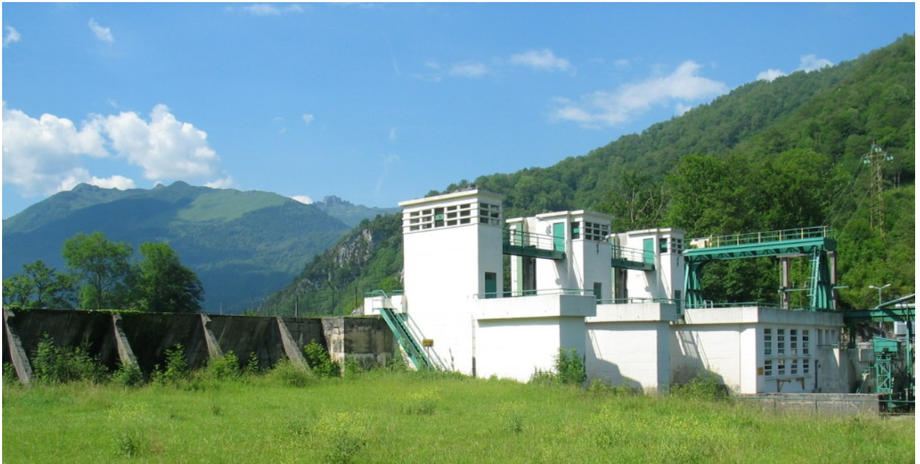
Figura 3.2: Visión general de la central desde aguas abajo [4]
