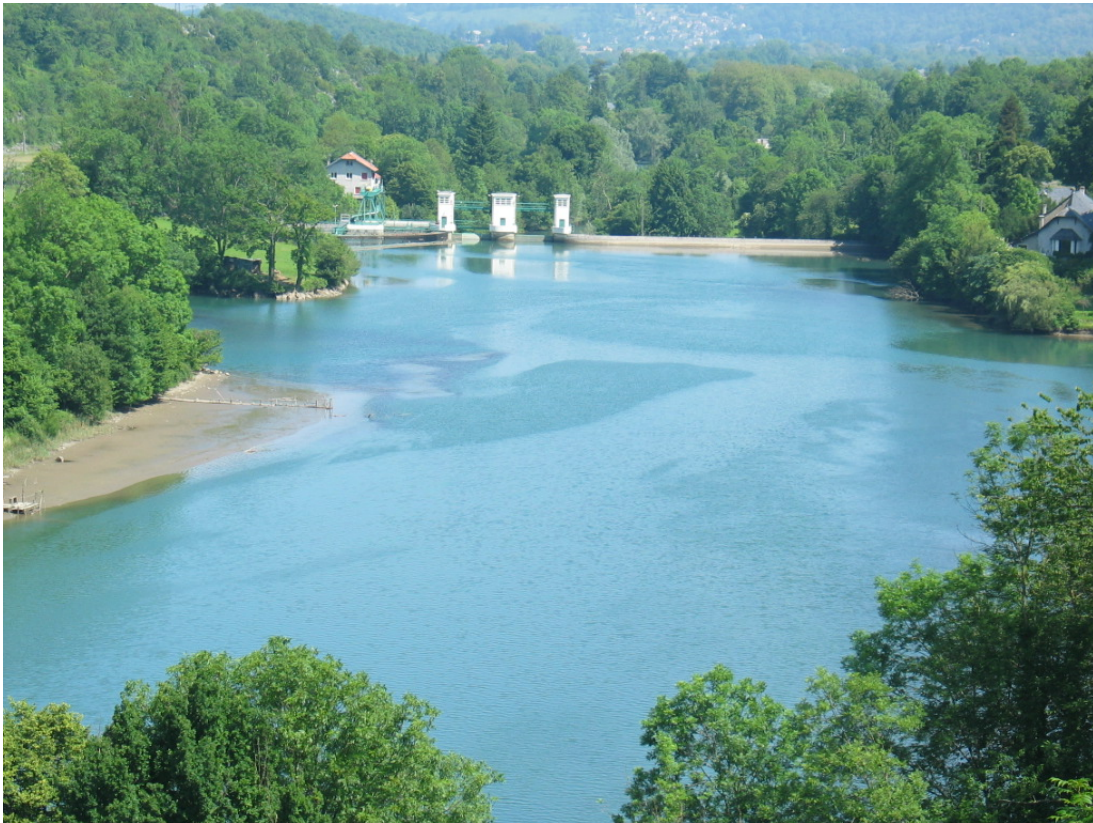
Figura 3.5: Vista de la presa [4]
