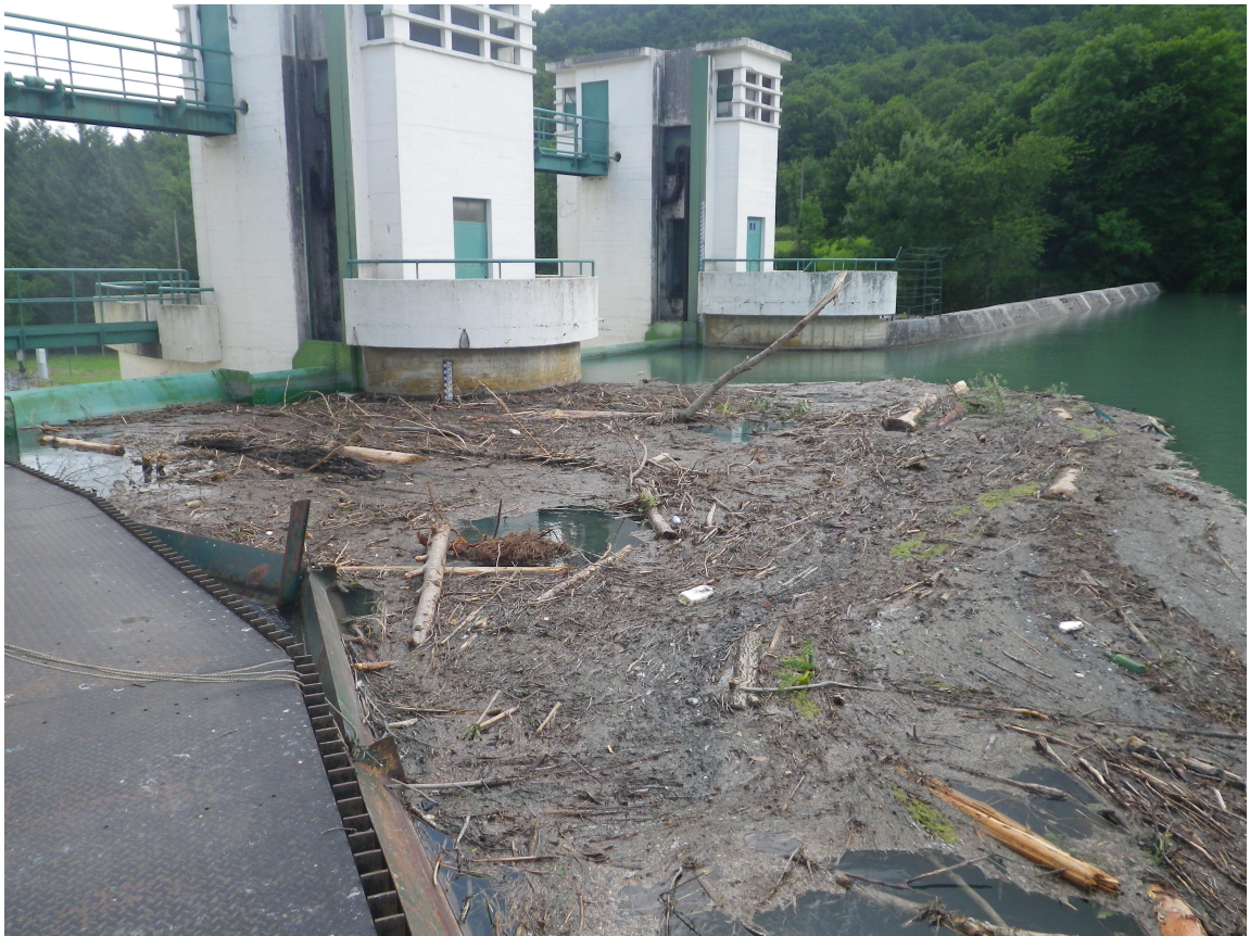
Figura 3.8: Boca de desagüe en la VC1 [4]
