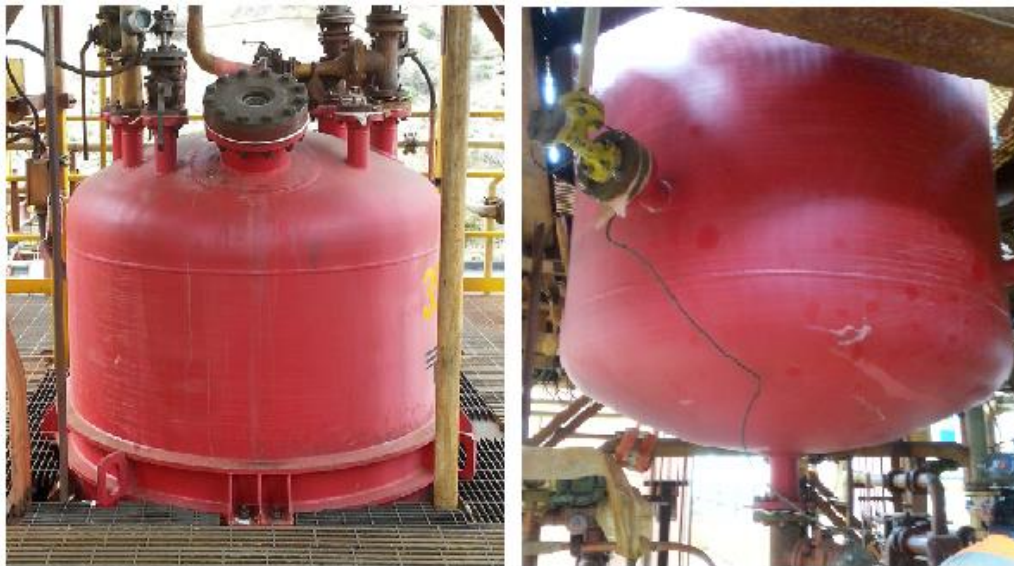
Figura 2-16. Equipo utilizado en el proceso de Cloración.
