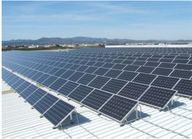
Ilustración 11 Disposición de paneles fotovoltaicos individuales
