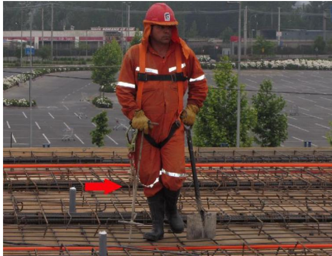
Figura 16: Operario con Chapulin
