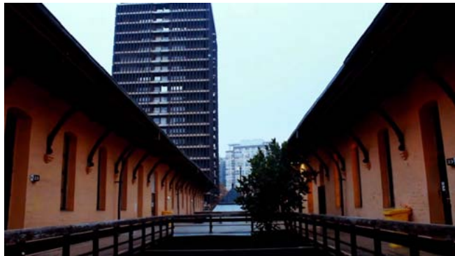
Patrimonio arquitectónico: Pasillos entre bloques.
