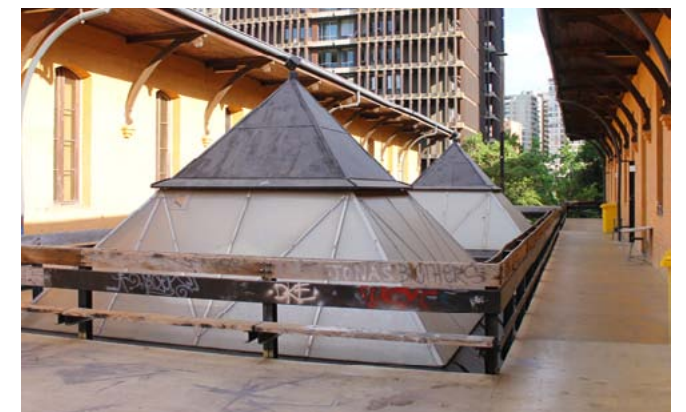
Segundo piso, entre pabellon C y D
