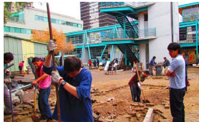
Construcción comunitaria plaza frente a la cancha
