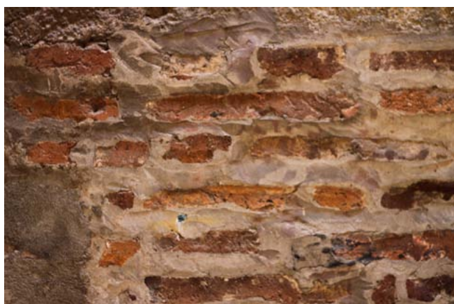
Albañilería al aire
