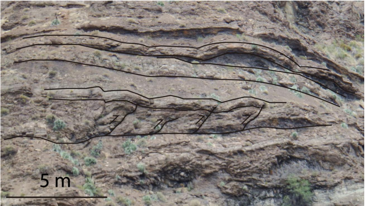
Figura 24: Cizalle entre estratos en estero El Manzanito, en los estratos superiores de la fotografía se observa un pliegue por detachment y en los inferiores; pequeñas fallas inversas.
