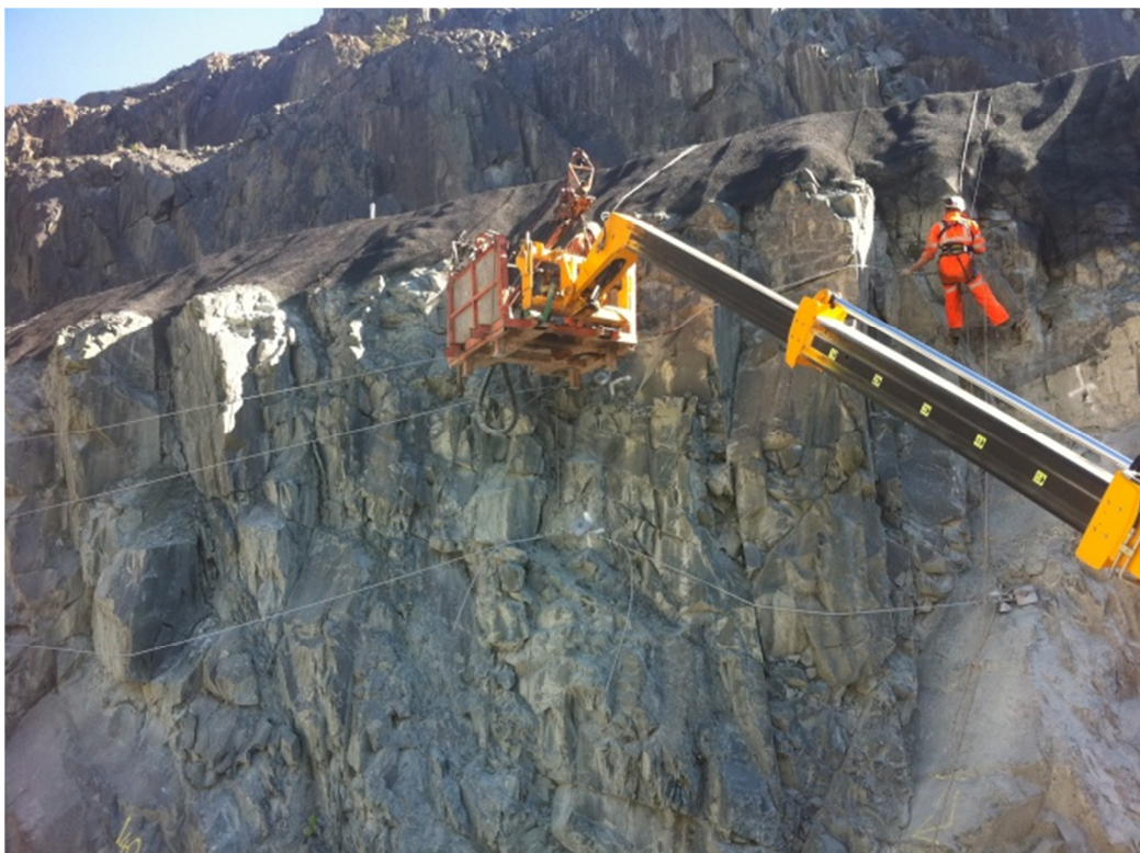
Figura 18: Instalación de fortificación de malla (Case Study: Rock Bolts and Rockfall Netting, Ingleton Quarry, www.can.ltd.uk ).
