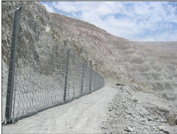
Figura 19: Aplicación de Mallas de Captura en faena (Open-Pit Rockfall Protection System, www.pythongroup.ca ).
