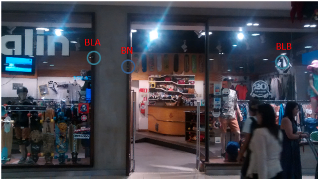
Figura 4.19: Instalación de Sistema
