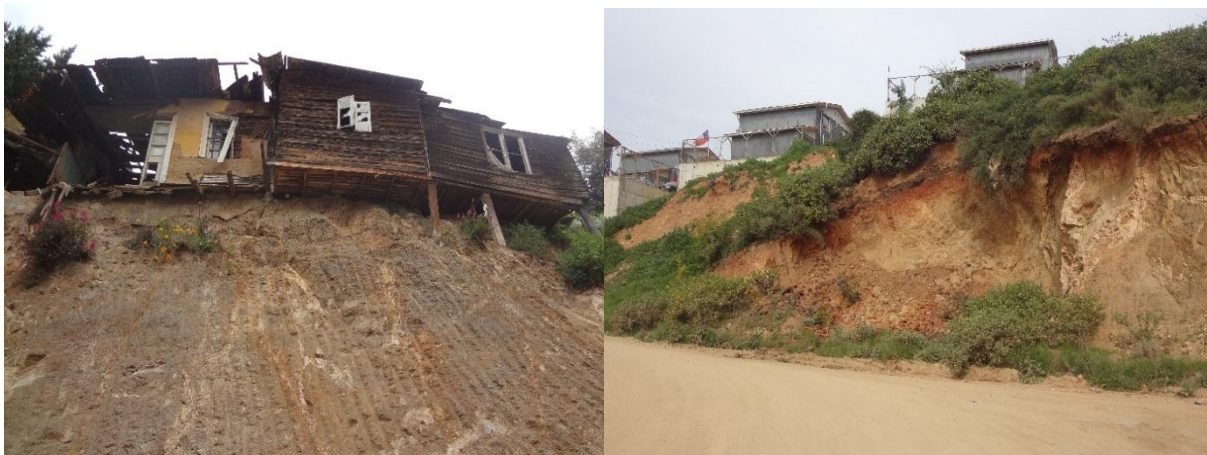
Figura 4.9: Cortes artificial en ladera. A la derecha, corte asociado a deslizamiento de suelo histórico, posiblemente para retirar material disgregado o en condiciones de desestabilización (Coordenadas UTM: 257060/6339405), a la izquierda, corte asociado a ensanchamiento de ruta vehicular, se observa un horizonte de suelo de un espesor de 2 mts aproximadamente (Coordenadas UTM: 258902/6337352).
