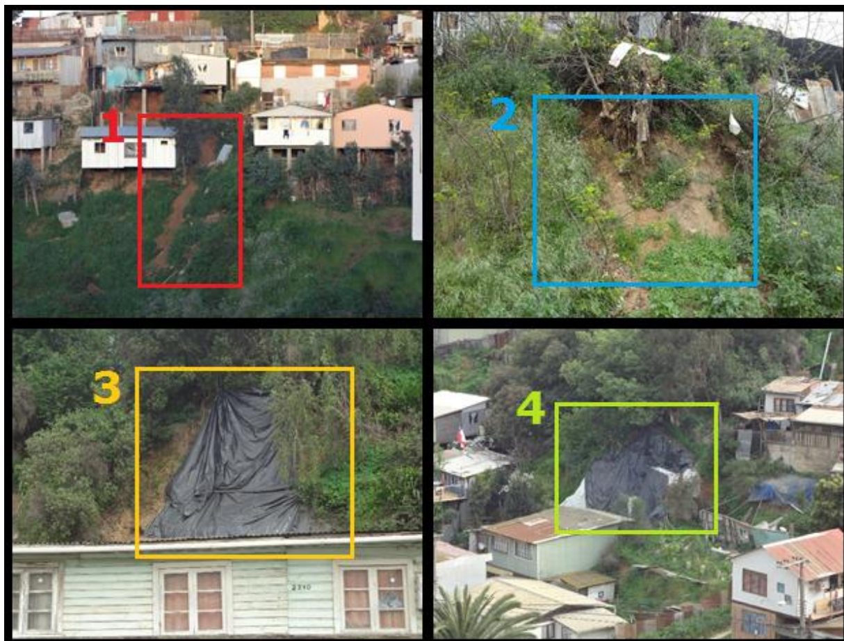
Figura 4.11: Eventos declarados en la zona estudiada. En la imagen 1 se puede observar un flujo de detritos de proporciones menores, asociado a una quebrada secundaria o posiblemente sólo a una ladera. La imagen 2 muestra indicios de remociones en masa de tipo deslizamiento superficial, dejando expuesta raíces de árboles aledaños. La imagen 3 y 4 muestran métodos de mitigación a la posible saturación de los suelos adyacentes, producto de lluvias invernales.
