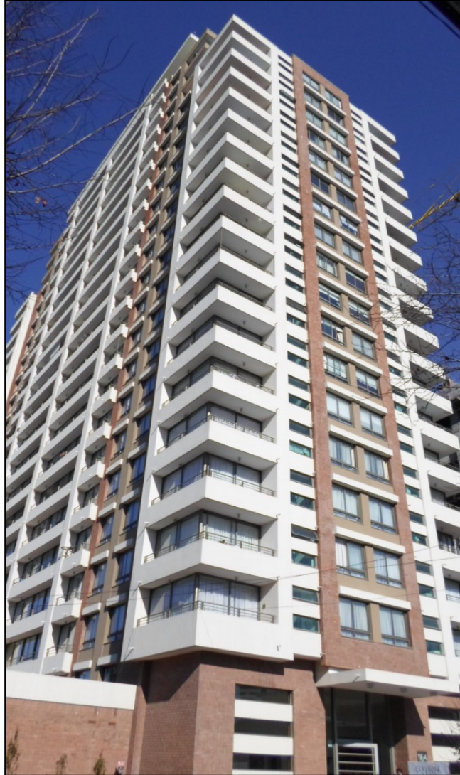
Imagen 3: Edificio Cochrane. Ubicado en Calle Cochrane 1164. De Inmobiliaria La Brabazon S.A. Representada por Ricardo Bachelet Artigues. Año de edificación: 2010. Fuente: elaboración propia. 2013.
