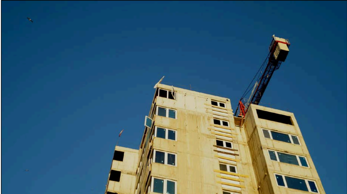
Imagen 1: “ Edificio en construcción ”. Calle Chacabuco. Concepción, Chile. 2014. Fuente: Elaboración propia.
